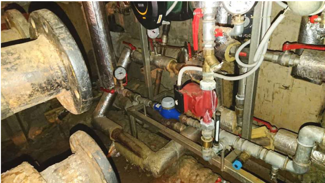
12.att. Ēkas pagrabā javeic siltummezgla sakārtošanas darbi, kas saistīti ar apkures sistēmas atjaunošanu.
