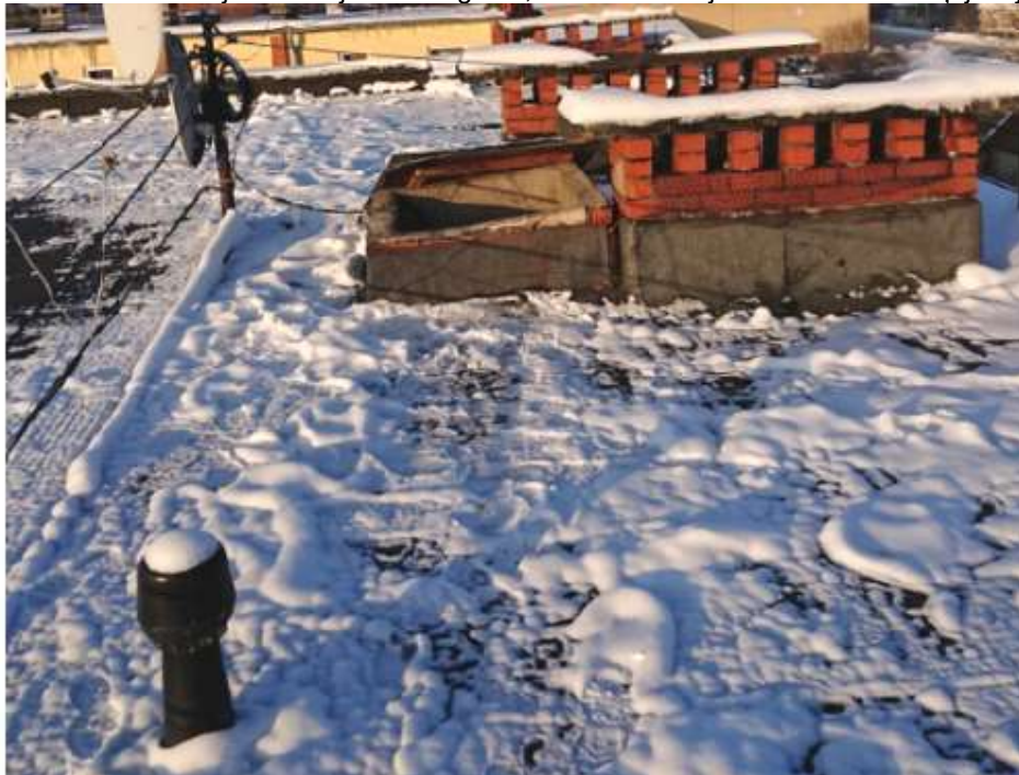
18.att. Redzams jumta deflektors; jumta lūka un ventilācijas izvadi.
